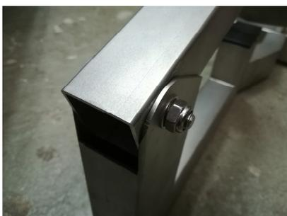
Anschließend die M8 Unterlegscheibe klein auflegen und die M8 Stoppmutter festziehen. Stellen Sie das Spiel individuell von locker bis stramm ein.
