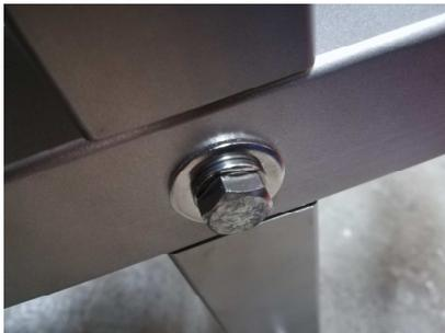
Die Traverse kurz und die Traverse lang des Grundgestells werden in die dafür vorgesehenen Aussparungen zusammengesteckt. Anschließend wird der Zentrierstab von oben durch beide Traversen gesteckt und mit der M8 Außensechskantschraube fest verschraubt. Vor dem Einschrauben der M8 Außensechskantschraube werden erst der M8 Federring und dann die M8 Unterlegscheibe groß aufgelegt.
